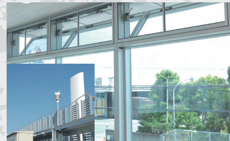
天候センサーと自然喚起システム（河西工業 本社 技術新棟） Weather sensor and automated ventilation system (KASAI KOGYO CO., LTD. Headquarters, New Engineering Building)
